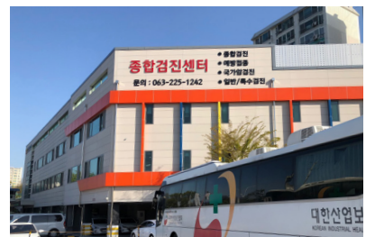
건물 증축 후
