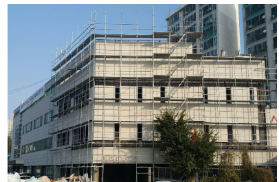
건물 증축 공사
